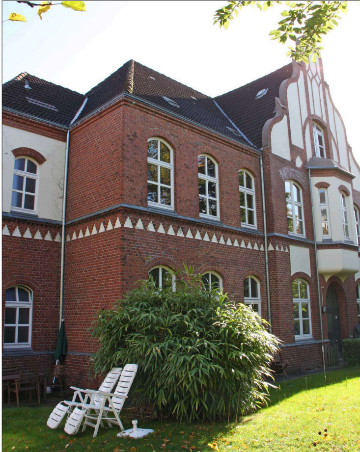
Auch das Dachgeschoss des ehemaligen Inspektorenhauses in der Adalbertstraße 6 soll nächstes Jahr saniert und ausgebaut sein. Fotos eyes
